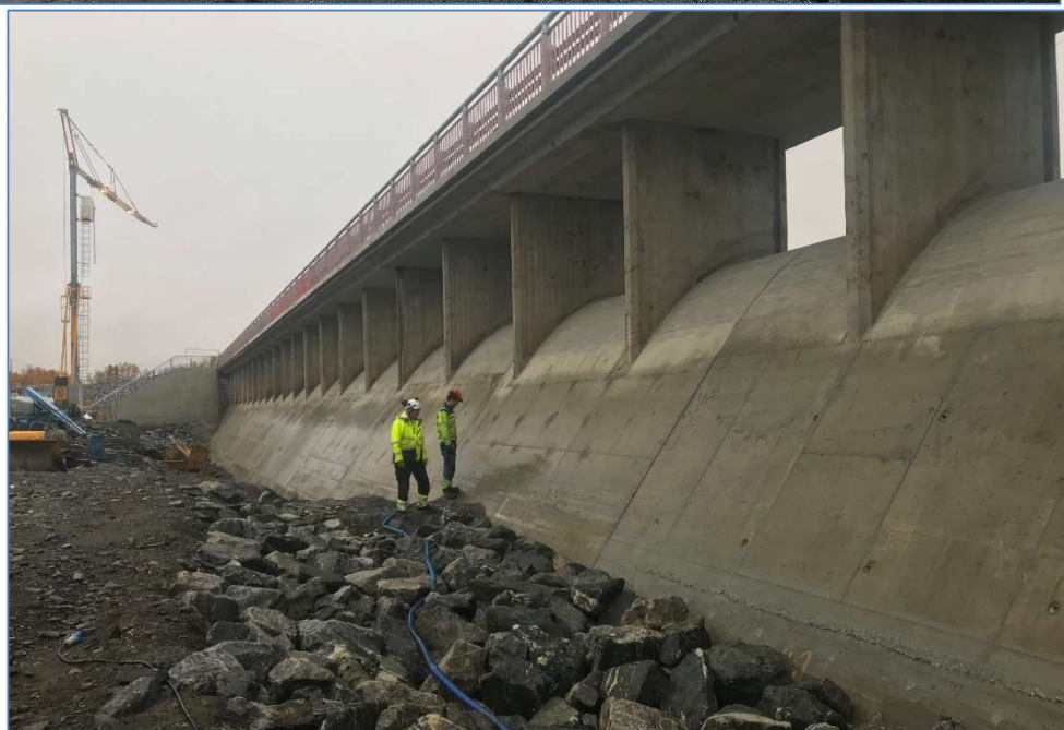
Flyvatn. Ferdig Overløpsdam Foto: Øyvind Eidsgård
