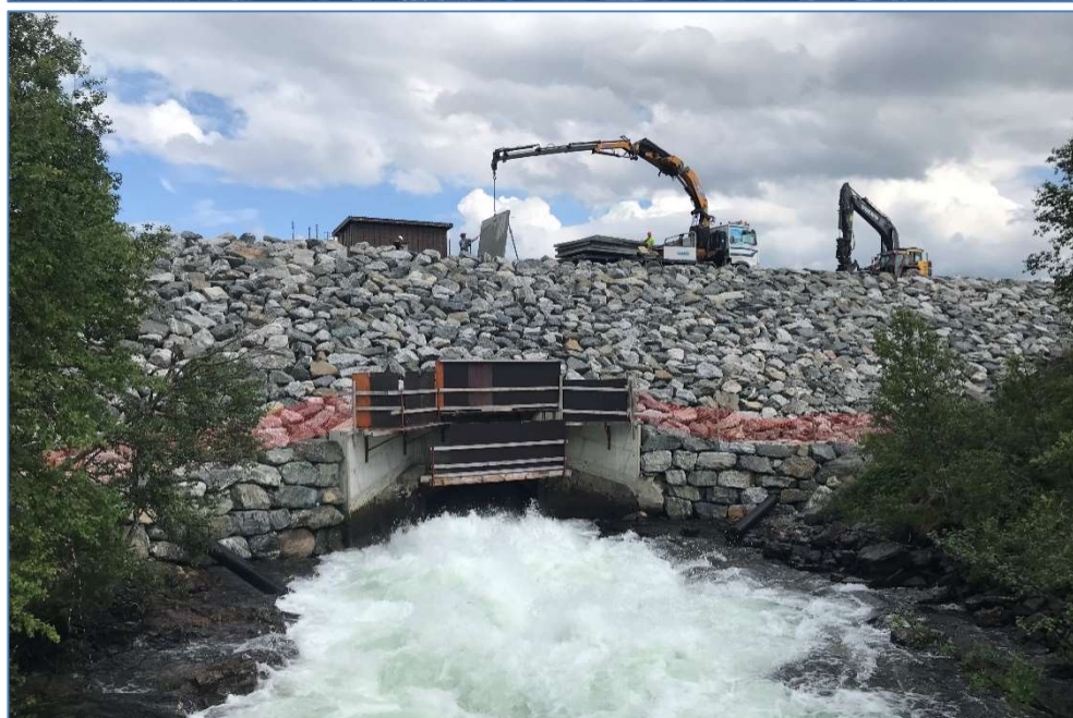
Flyvatn. Nedstrøms dam ved tappekulvert Foto: Øyvind Eidsgård
