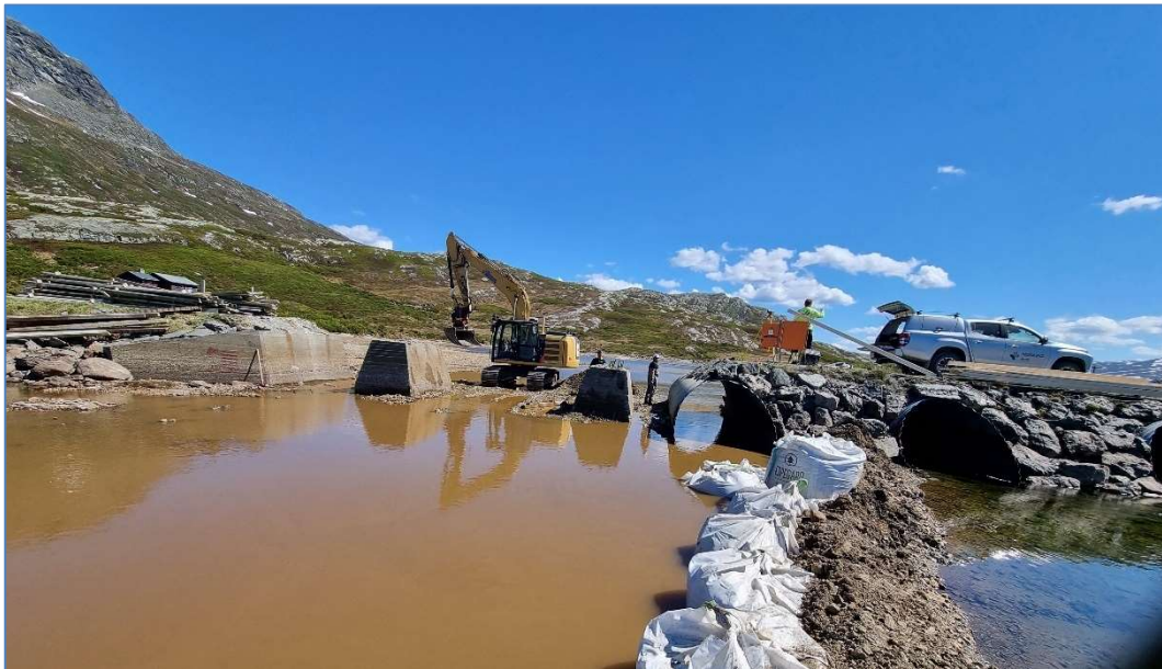
Fleinsendin. Bru over Sleipa under reparasjon. Foto: Øyvind Eidsgård
