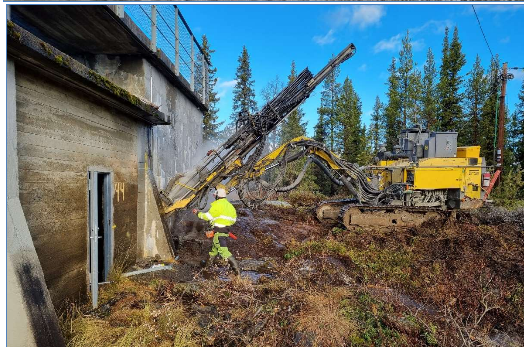
Bløytjern. Tetting av en brysom lekkasje. Foto: Steinar Myreng
