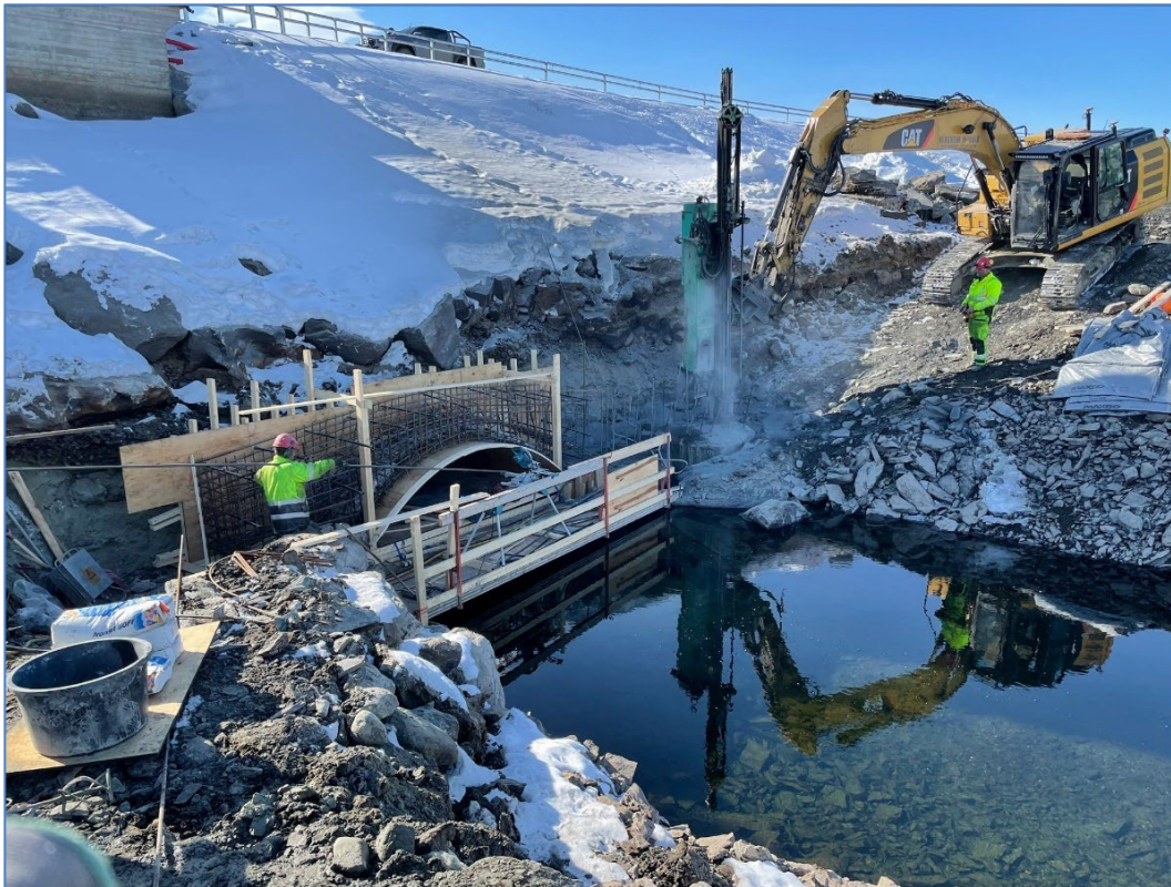
Flyvatn. 23. mars. Reparasjon av innløpet til tappekulverten Foto: Øyvind Eidsgård
