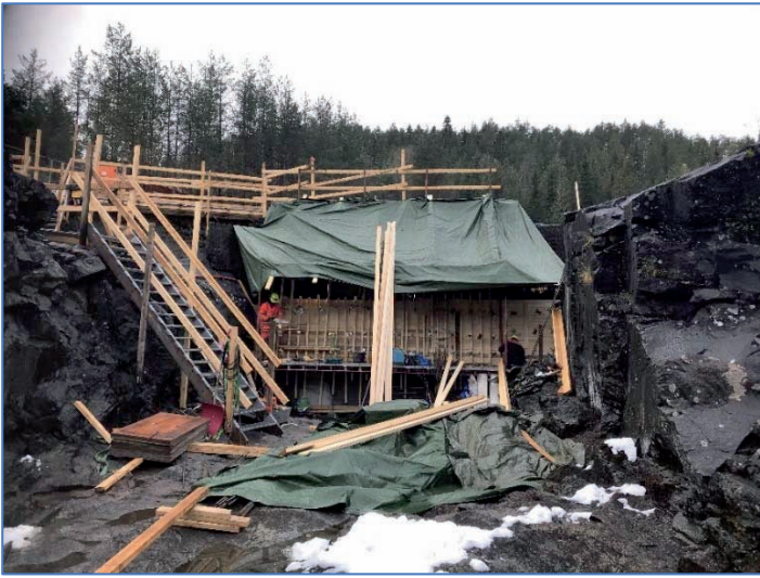
Fasle elv. Reparasjon av bjelkestensel. Foto: Øyvind Eidsgård
