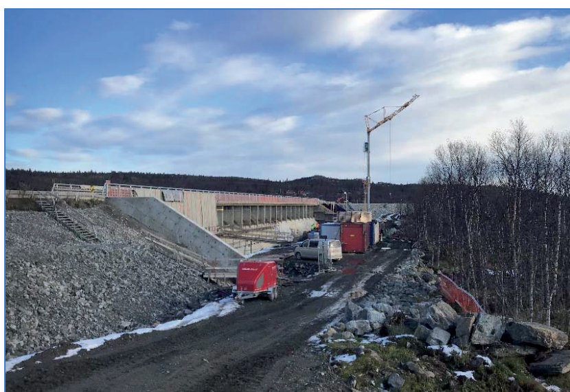
Flyvatn. Plastring dam øst, og betongarbeider på overløp Foto: Øyvind Eidsgård
